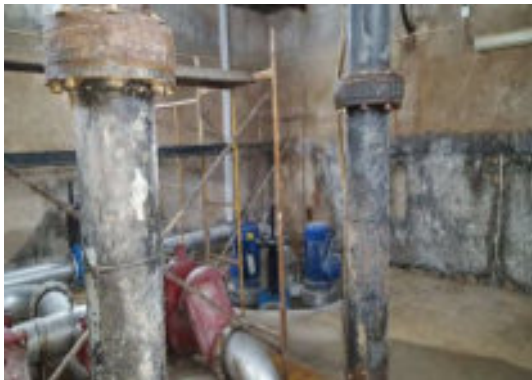
Antes da Intervenção
