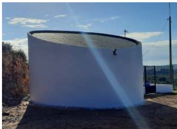
Fig. 4 - Reservatório de Santa Catarina
