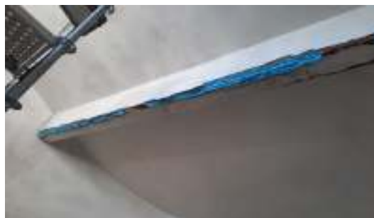
Fig. 3 - Reservatório de Santa Catarina - manutenção
