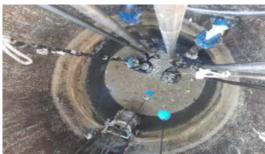
Fig. 11 – Sistema de bombagem para a EEAR de Santa Luzia I
