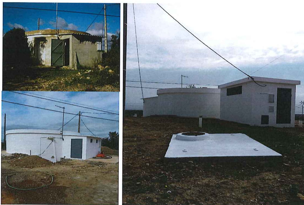
Reservatório de Monte Agudo (Sto. Estêvão)
