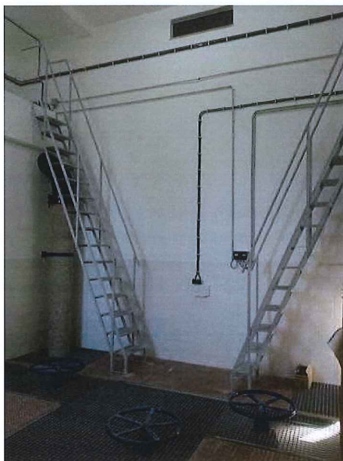
Reservatório da Boavista – Instalação de escadas fixas de acesso às células
