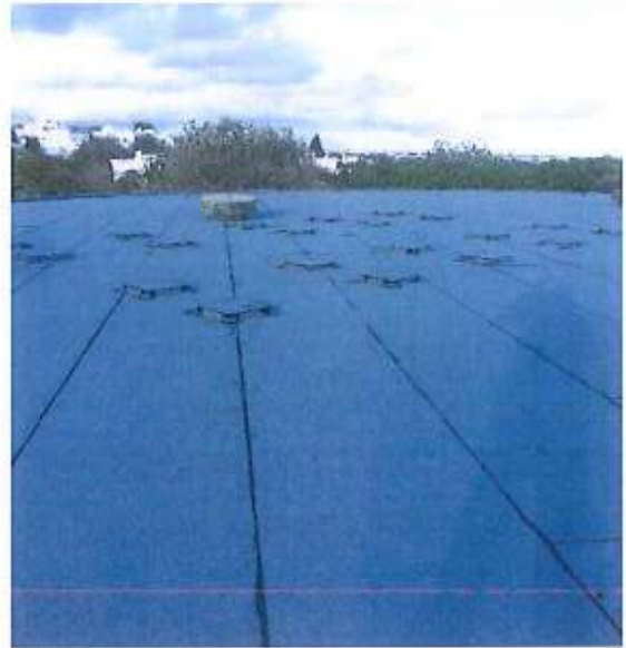
Reservatório Perogil – Impermeabilização
