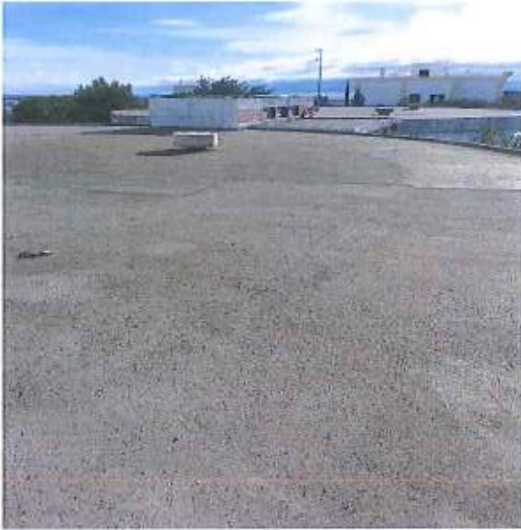
Reservatório Perogil – Impermeabilização
