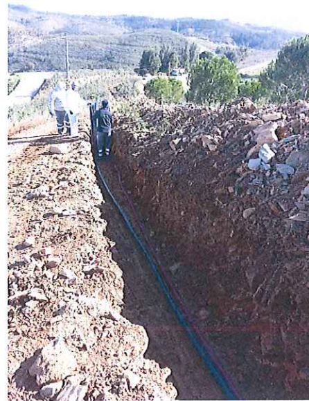
Furo do Moinho – Enterramento de cabos
