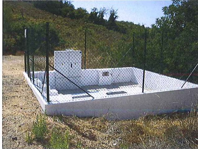
EEAR Perogil 2 após a intervenção de reabilitação
