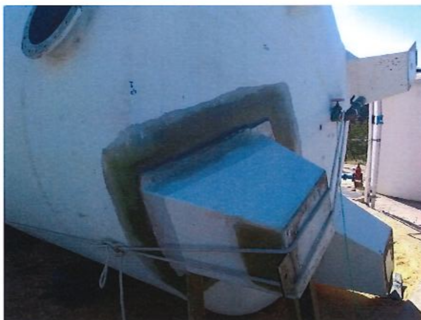
Reparação de reservatório de água de abastecimento em fibra da ETA do Bengado
